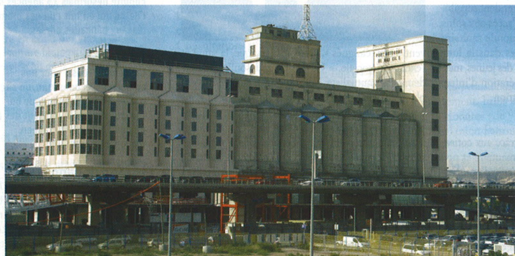
Le silo d'Arenc, symbole de l'architecture industrielle marseillaise, construit en 1927, long de 130 mètres, large de 25 et haut de 50, était destiné à la compagnie des Docks et Entrepôts de Marseille. C'était à l'origine l'un des plus vastes et des plus modernes silos du monde. Il a été désaffecté à la fin des années 80 et a failli être détruit lorsque le projet de la gare maritime a pris forme.
